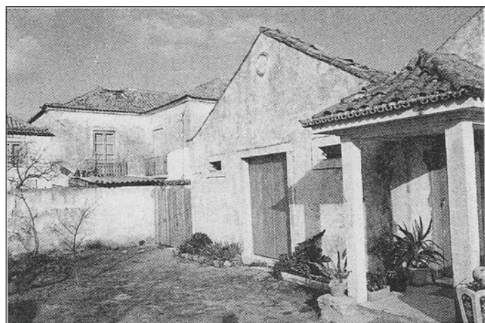
Fig. 15: Actuais edifícios da antiga Quinta de Cheira Ventos, onde existiu uma Capela dedicada S. João Baptista. 105
